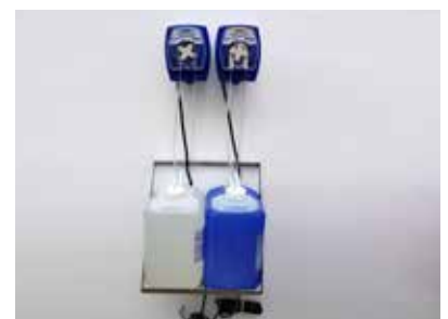
Dosador individual para máquina de lavar louças
